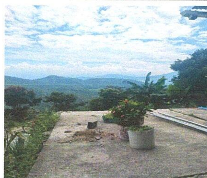
Foto 4: Mejoramiento 18.75m² de cerco perimetral colocando malla con tubo galvanizado para resguardar la integridad fisica de niños y niñas de nuestro establecimiento.
