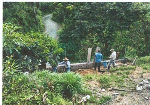
Foto 2: Mejoramiento de 38m² de muro de contencion para resguardar la integridad fisica de sniños y niñas de nuestro establecimiento.
