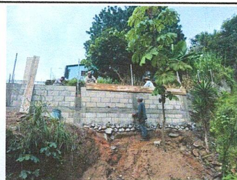
Foto 3: Mejoramiento de 38m² de muro de contencion para resguardar la integridad fisica de sniños y niñas de nuestro establecimiento.
